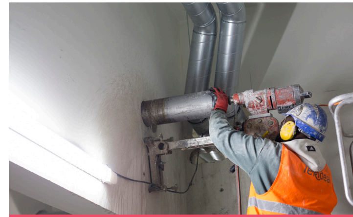
À l'aide d'une carotteuse, les compagnons de Terideal Proclim créent des ouvertures dans les murs en béton pour le passage des réseaux de chauffage, ventilation et climatisation.
