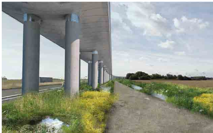
Portion du viaduc située le long de la RN 118 entre les futures gares Orsay – Gif et CEA Saint-Aubin.
